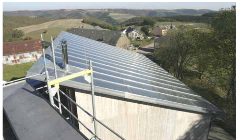
Centrale d'énergie capteurs solaires thermiques
