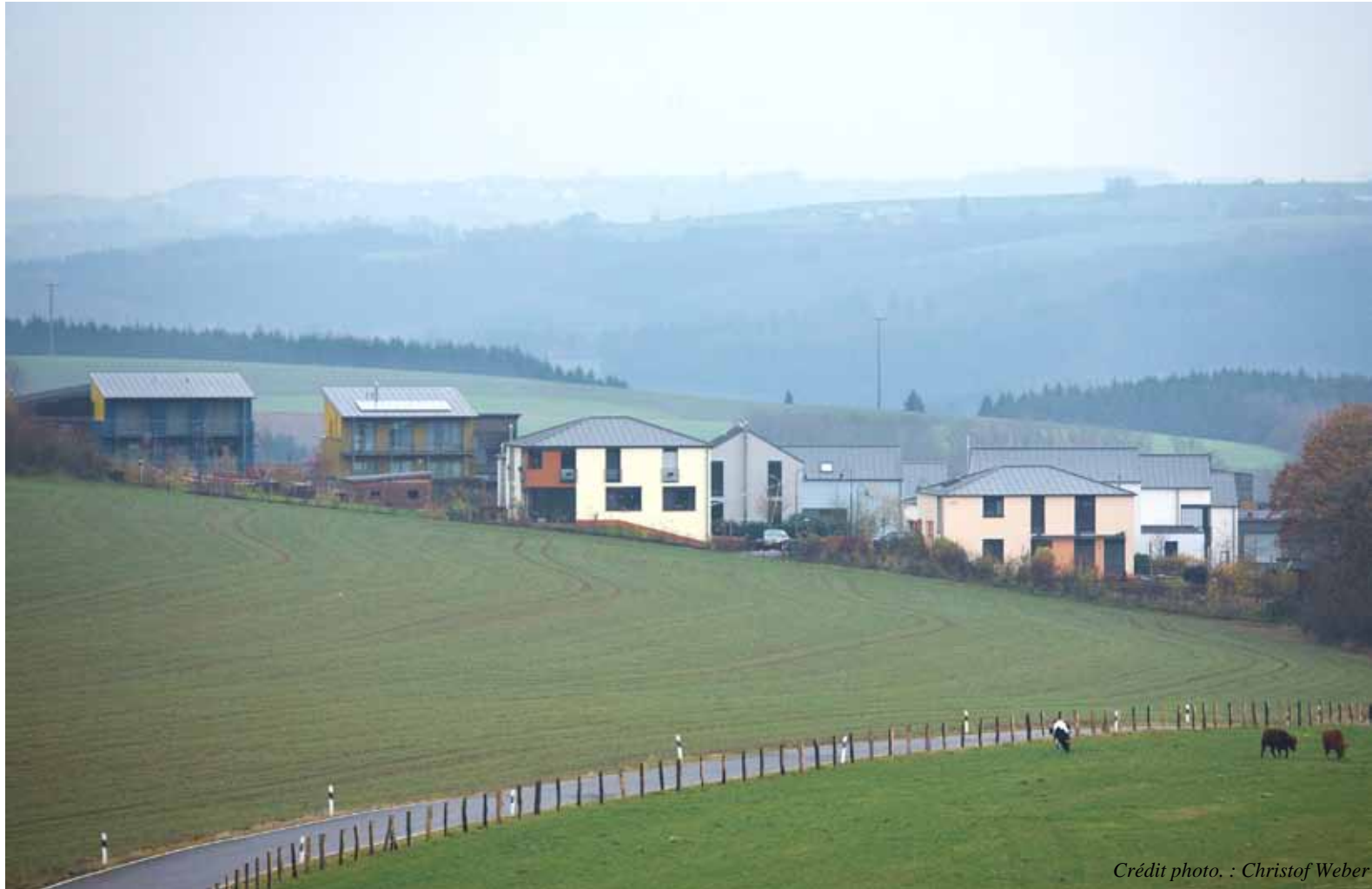
Vue de l'ensemble / Façades sud
