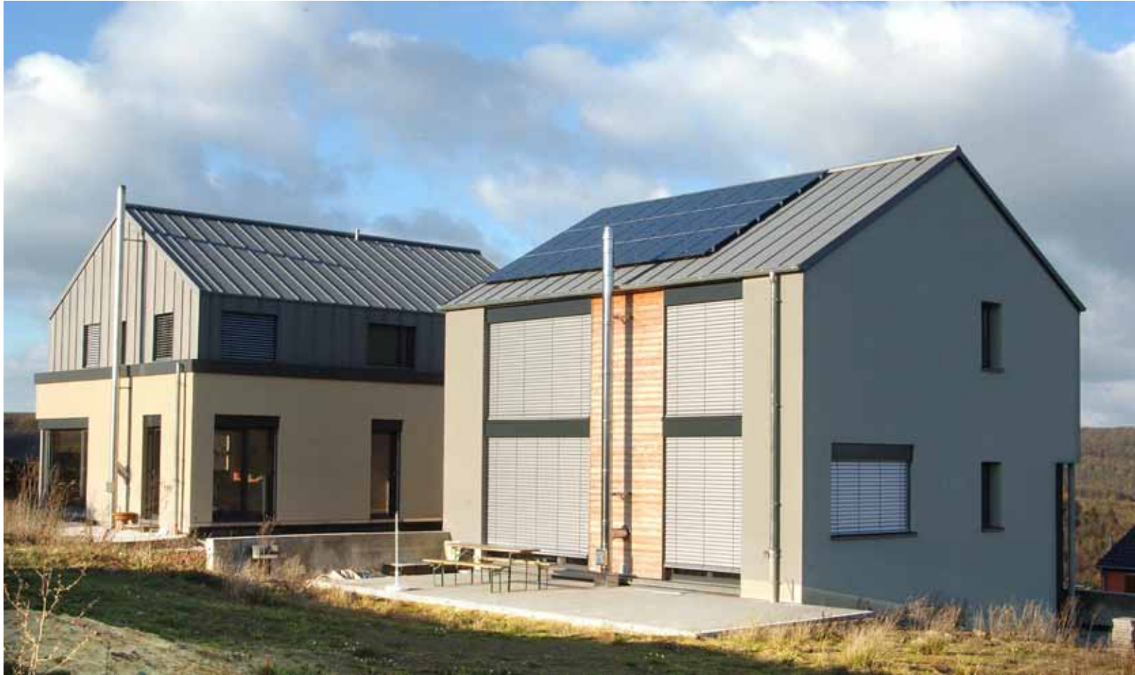
Façades sud des maisons le long de la rue principale
