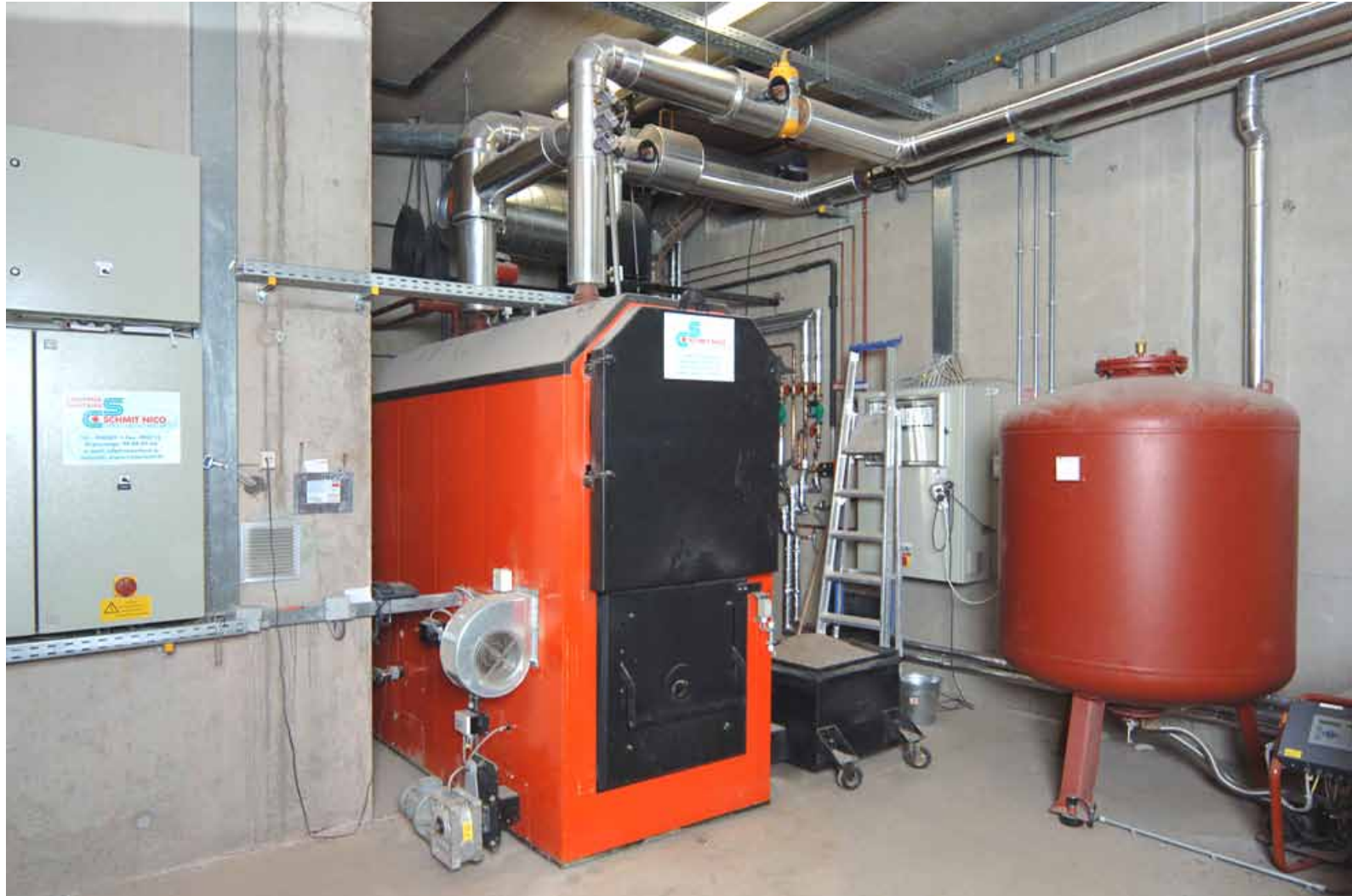
Centrale d'énergie Chauffage à base de copeaux de bois
