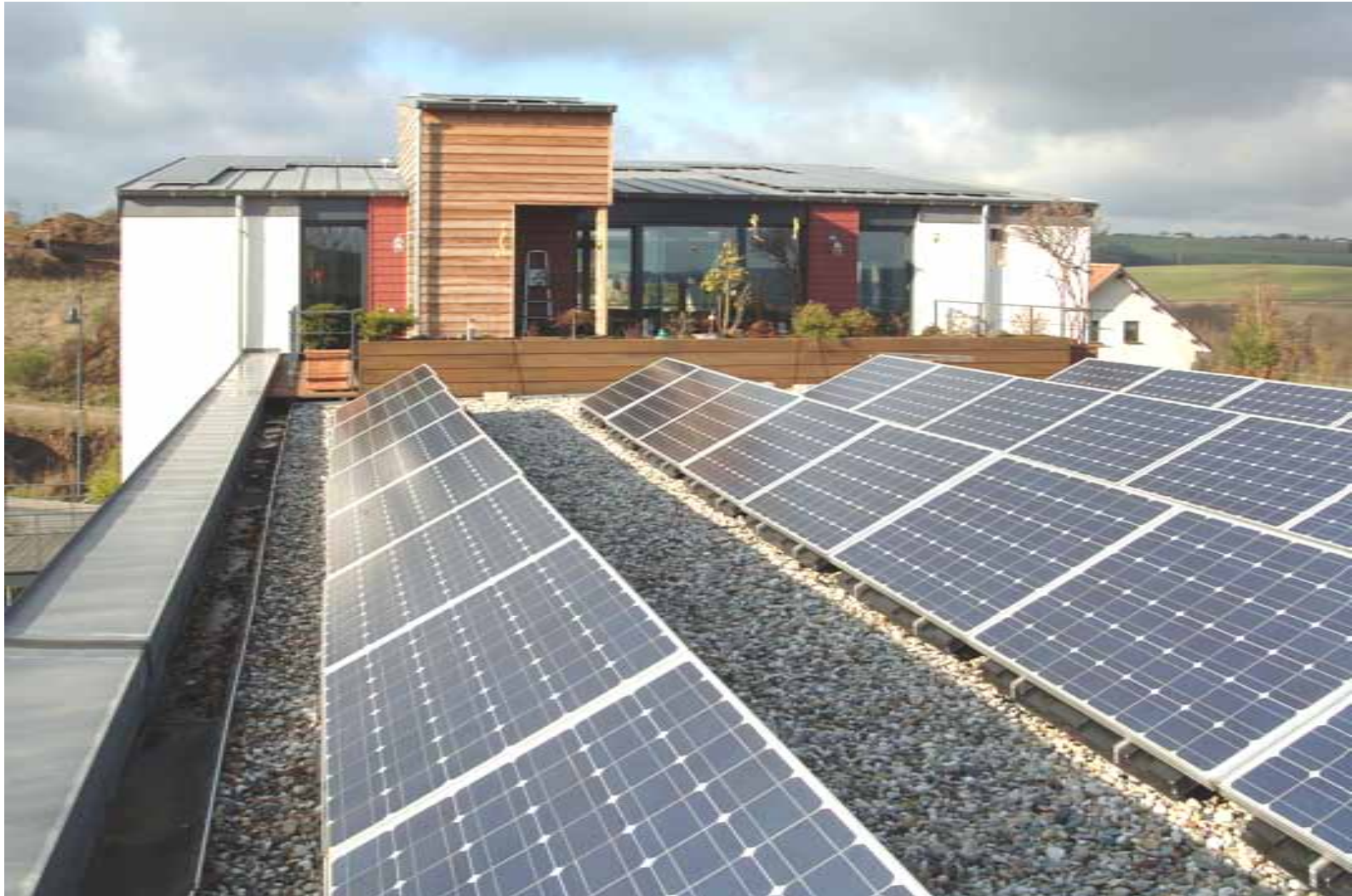
Appartements / Maisonnettes - Installation de cellules photovoltaïques sur toit-terrasse
